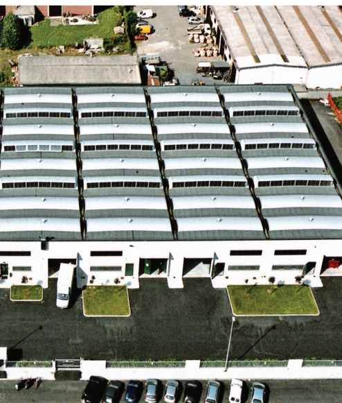
Sede centrale e fabbrica di Essedue a Cura Carpignano (PV)
